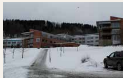
Feiringklinikken eies av LHL og er både sykehus og rehabiliteringssenter.
